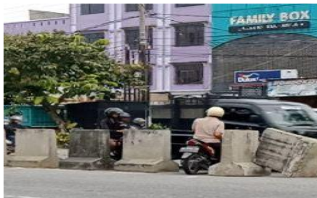
Gambar 2. Pelanggaran Penggunaan Road Barrier di Jalan
