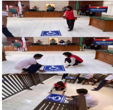
Gambar 3. Pemasangan tanda disabilitas diruangan sidang utama.
